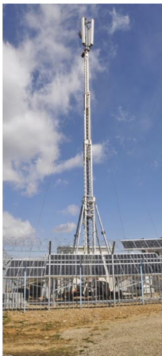
Bazna postaja, kjer del potrebne energije zagotovijo sončne celice. Postavljena je na samotnem griču 35 km od Prištine in zavarovana z ogrado in bodečo žico.
